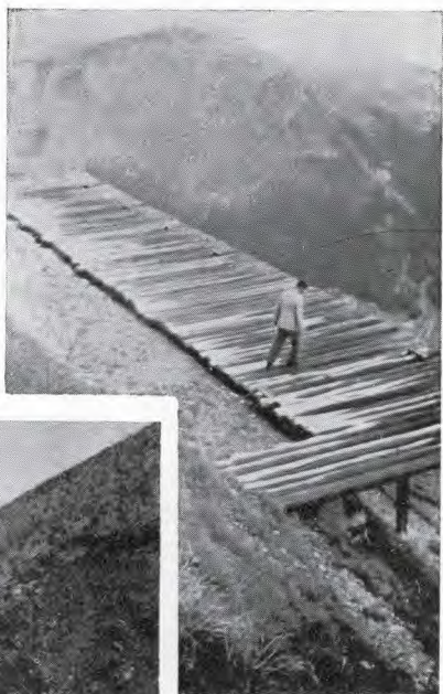
6. Renforcement d'une terrasse par un balcon à neige.
