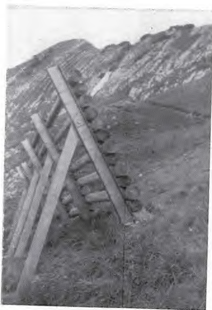
15. Pont à neige : Les éléments du platelage sont parallèles à la ligne de niveau.
