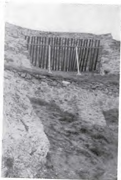
14. Râtelier. L'ouvrage charpenté est plus économique. Les brèches des murs sont réparées à l'aide de râteliers.
