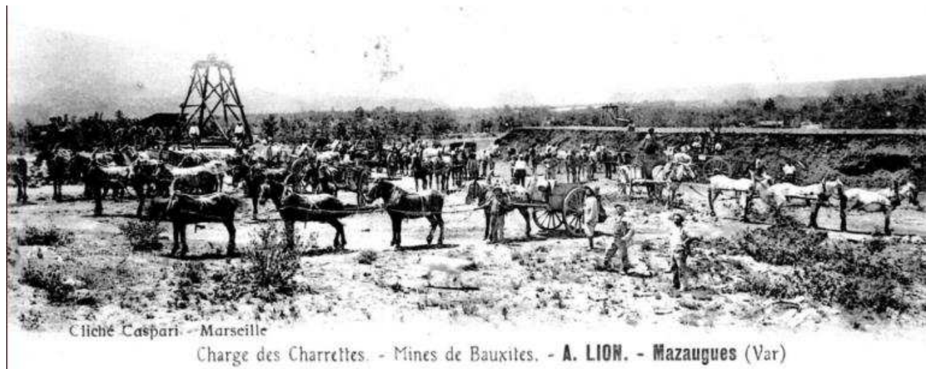
Figure 62 : Chargement de la bauxite à Mazaugues (source : Archives départementales du Var - Droits réservés)
