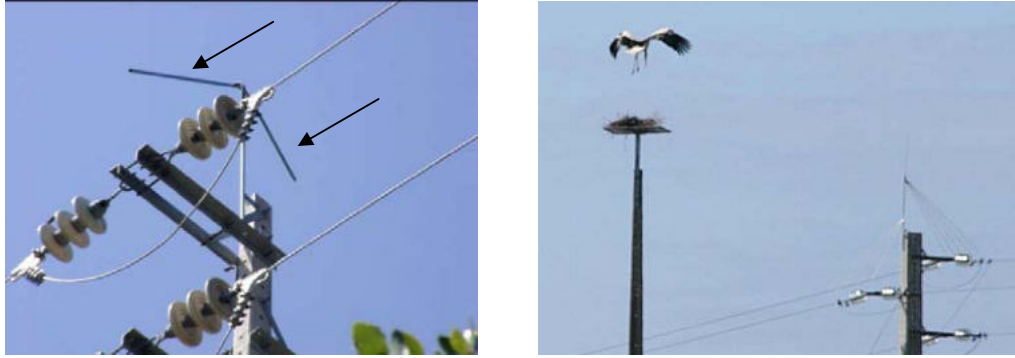
Figure 5. Poteau de distribution portant sur son sommet un équipement d'exclusion des oiseaux formé de chevrons symétriques (indiqués par les flèches) (Photo: EDP-Distribution, Portugal) et poteau destiné à la nidification de la Cigogne blanche installé à proximité d'un poteau de distribution portant un équipement d'exclusion des oiseaux (Photo: Carlos Tiago).
