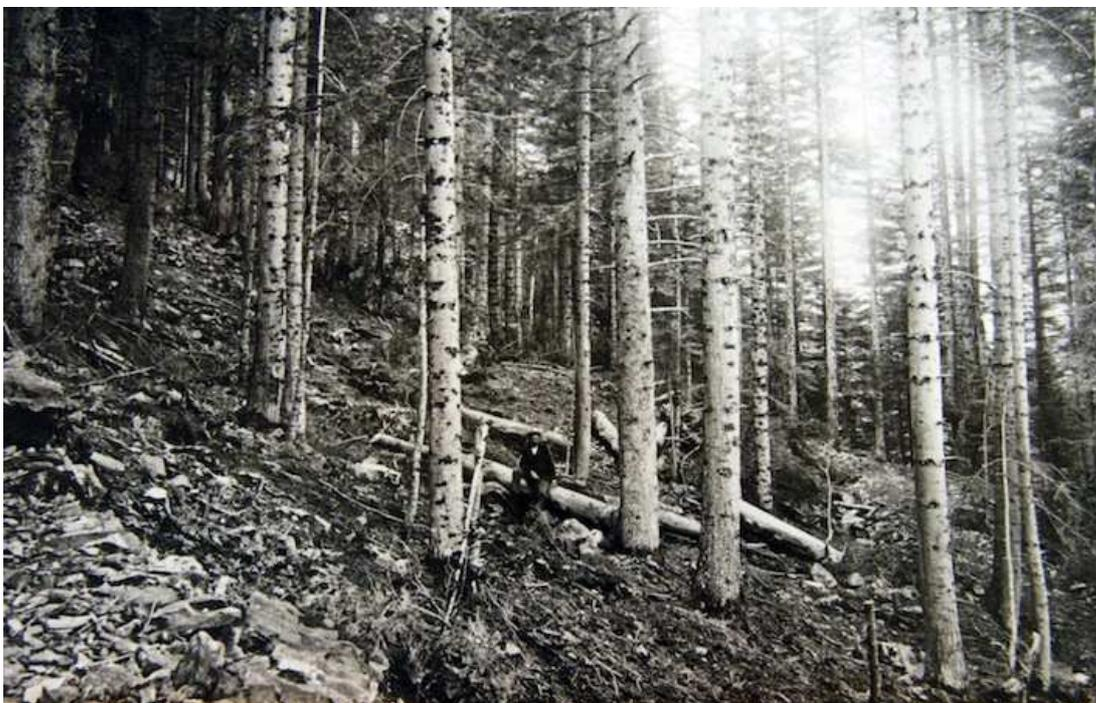
Figure 50 : En 1907, cette sapinière de la forêt syndicale de la Vallée de Barèges, dans la partie haute d'un versant, vient d'être équipée d'un chemin muletier horizontal (au premier plan à gauche) qui va permettre d'approcher les « rouls » - le personnage est assis sur l'un d'eux - d'un couloir de lançage<sup>261</sup>.
