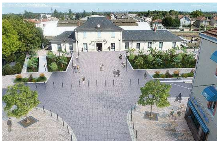
Gare multimodale de Pamiers (Source : ville de Pamiers)
